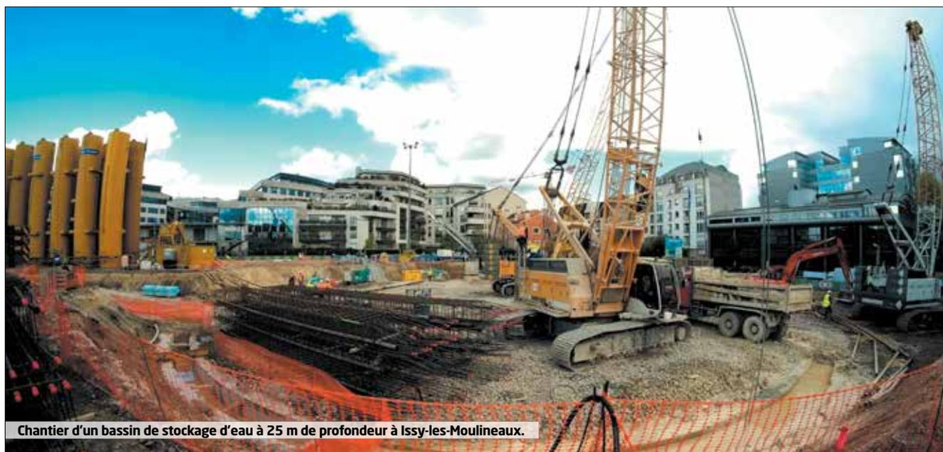
Chantier d'un bassin de stockage d'eau à 25 m de profondeur à Issy-les-Moulineaux.
