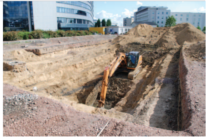
Sondage profond nécessitant l'aménagement de paliers de sécurité
