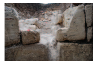
Détail du déversoir
