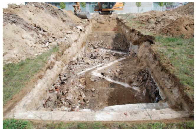
Vue des longrines des bâtiments anciennement présents sur la parcelle
