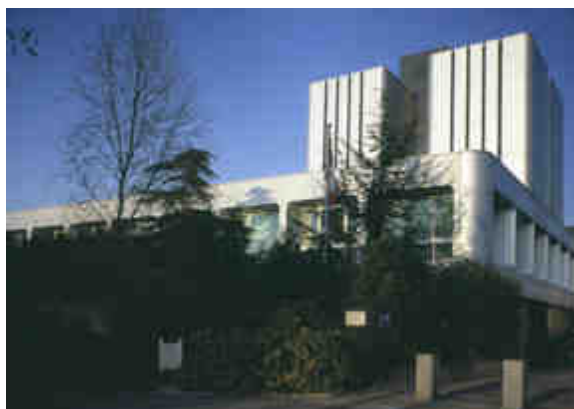
Vue du bâtiment des Archives départementales.
