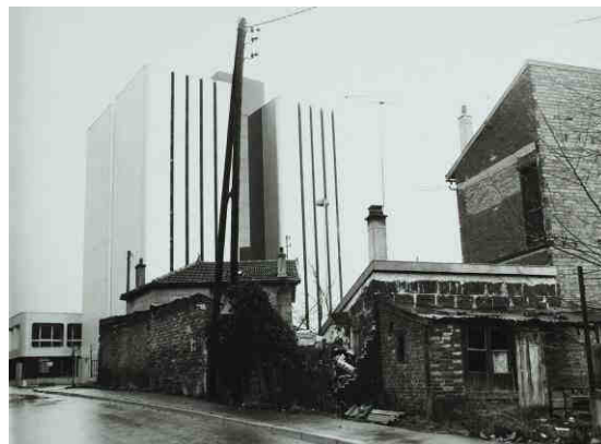
Construction du bâtiment des Archives départementales.
