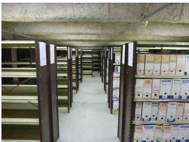
Une salle du 6 e sous-sol après traitement.
