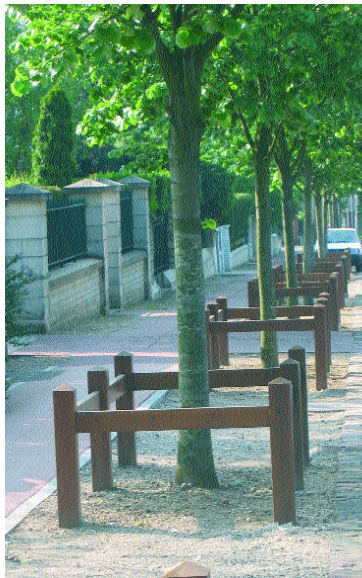
Un système de protection efficace - reste à planter les couvre-sols
