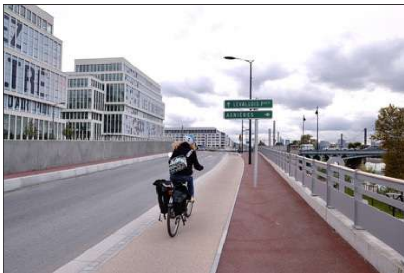
Quai de Clichy-Charles-de-Gaule (RD1) rénové avec voies pour voitures, cyclistes et piétons - © CD92-Julia Brechler
