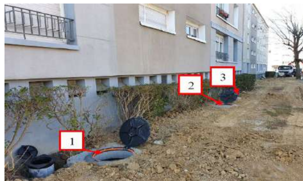
Gestion des eaux pluviales et mise en conformité des trois regards ©CD92
