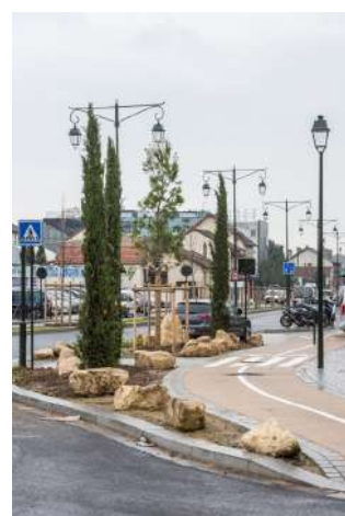
Lampadaires « LED » sur la RD906 à Clamart © Sennse CBadet
