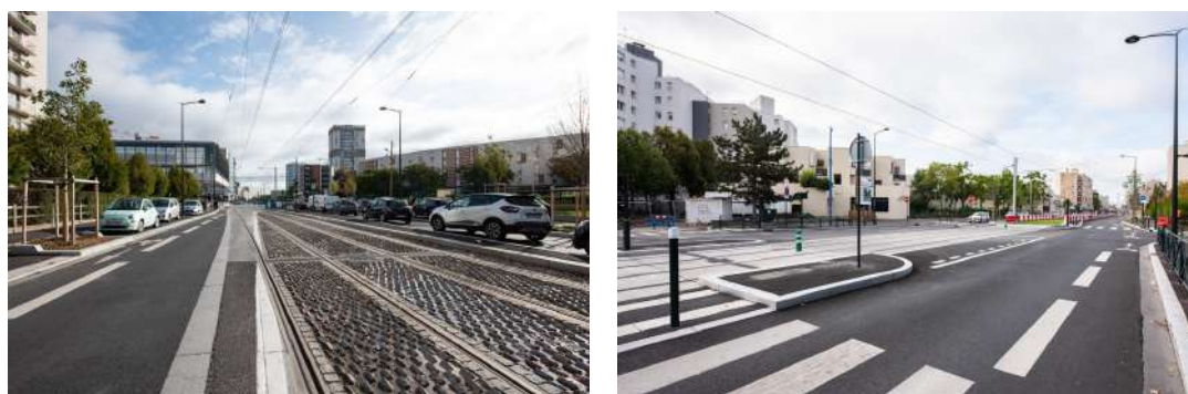
Travaux sur la plateforme du tramway © sennse_cbadet
