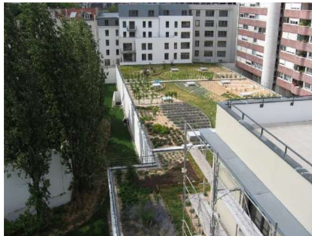
Toiture végétalisée de la résidence "Les toits de Boulogne" © CD92/DE
