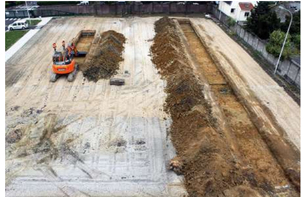
Réalisation des tranchées de diagnostic sur l'opération de la ZAC du Panorama à Clamart ©EPI 78-92/A. Konopka
