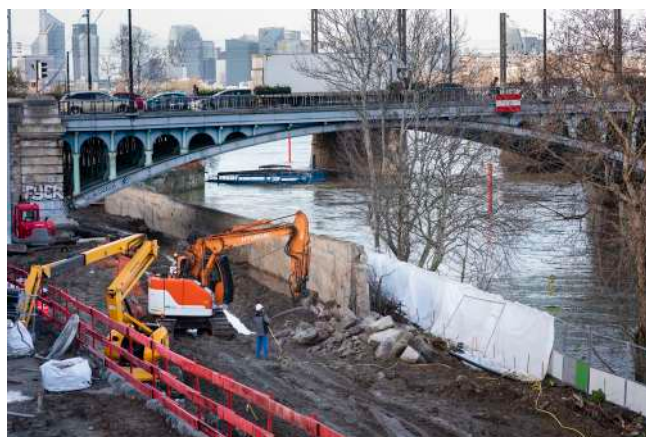
Travaux sur la RD1 à Clichy © Sennse-CBadet
