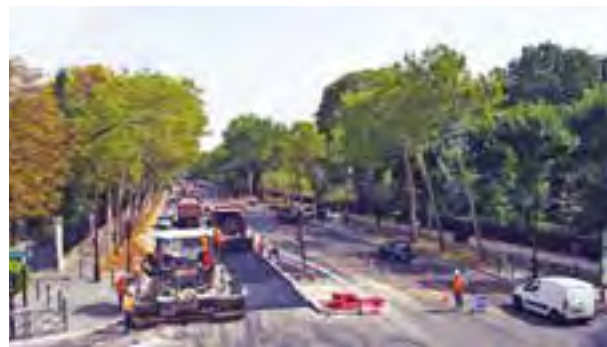
Mise en œuvre d'enrobés sur le chantier pilote de la RD 908 © Eiffage
