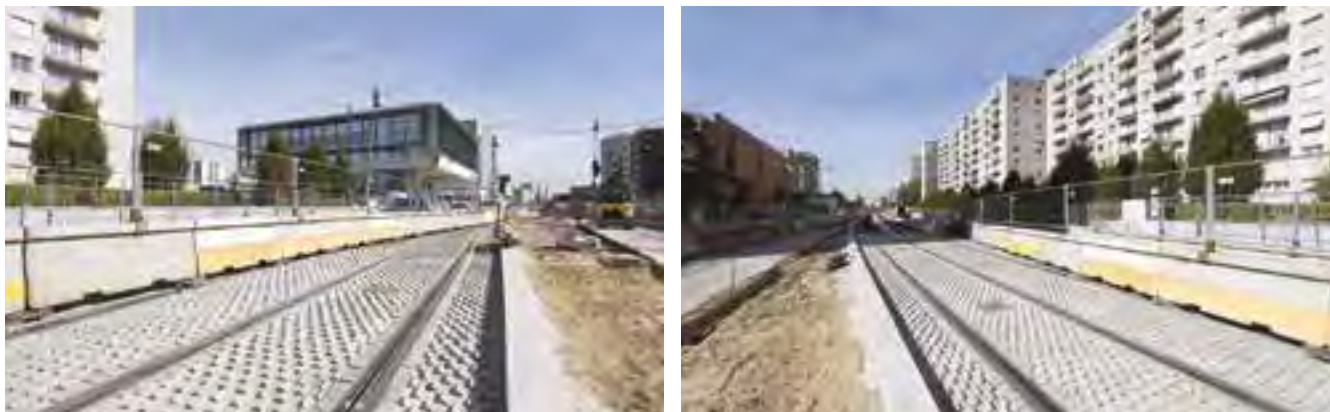
Travaux de plateforme tramway ©CD92/C. Badet
